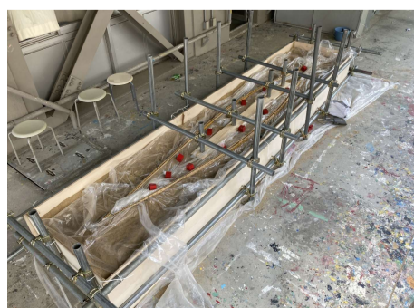
⑥型枠の設置
